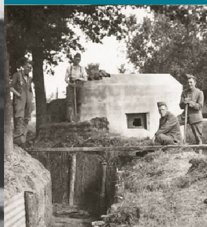
Nederlandse bunker in de gemeente Emmen
